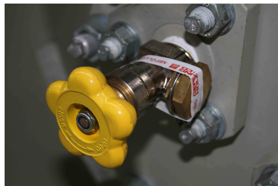
Obrázek č.6 Chlorový ventil na sudu GHC 600 kg namontovaný na tříhranné přírubě s ochrannou bezpečnostní těsnící maticí a plombovacím páskem
